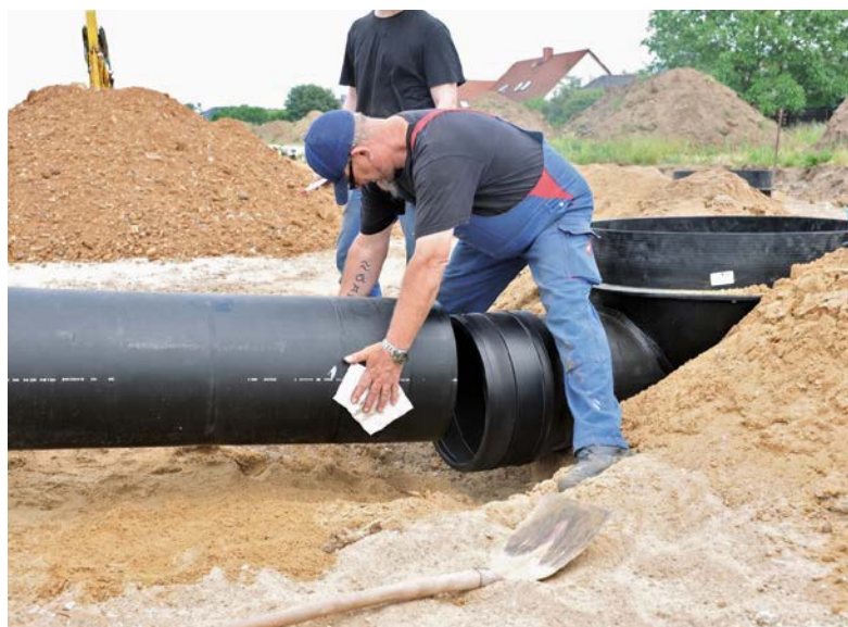
Baustellensichere Montage: PE-Rohrverbindung mit Elektroschweißmuffe
