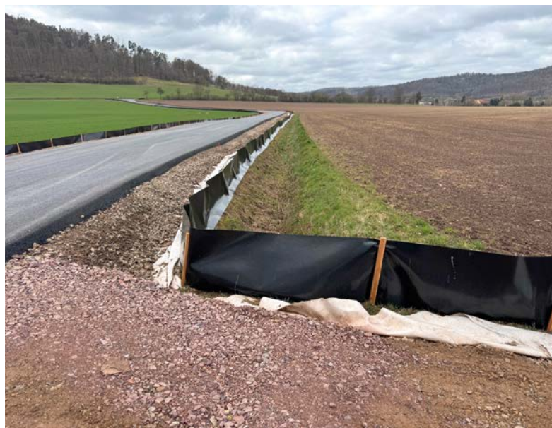
Praktische Anwendung von Amphibarrier™ 350 beim Bau des SuedLink
