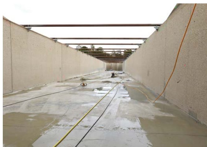
Frisch betonierte neue Betonsohle
