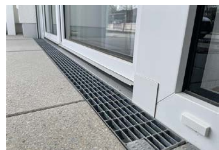
Niveaugleicher Übergang und zuverlässige Entwässerung im Terrassenbereich
